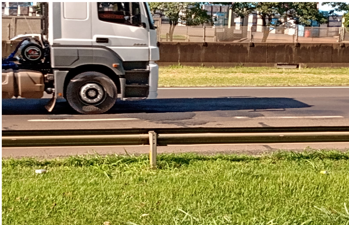
(FOTO ACIMA - REPARO INADEQUADO GERA BARULHO COM PASSAGEM CAMINHÕES)
