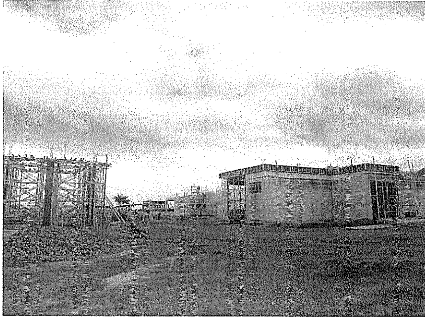
Vista geral das obras da ETA
