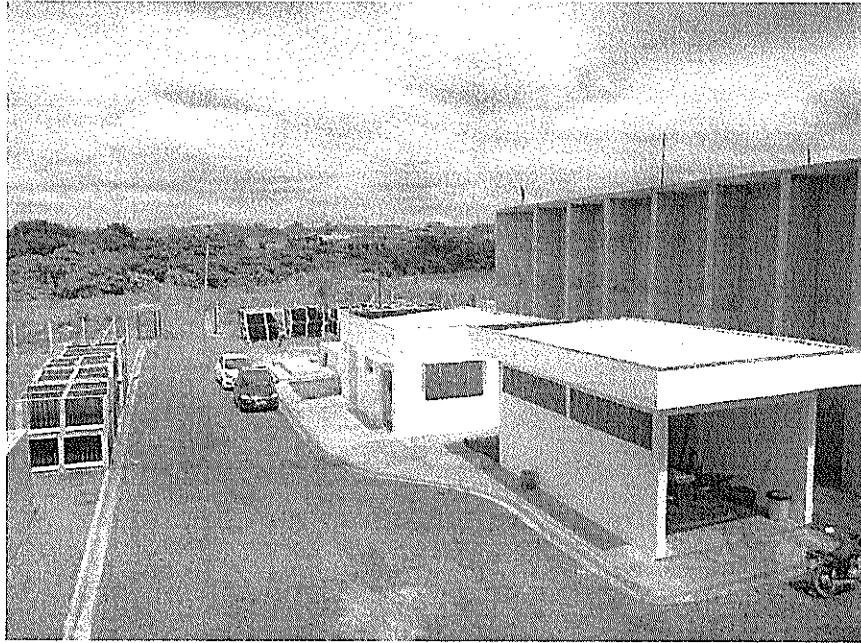
Vista geral da ETE
