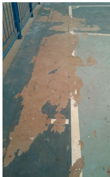
piso descascando
